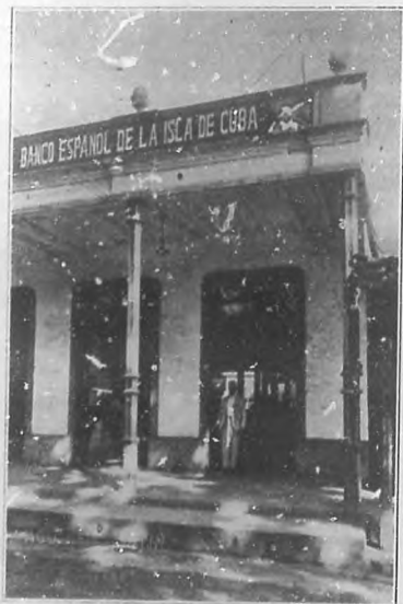
Fachada del edificio que ocupa el Banco Español en Placetas.
